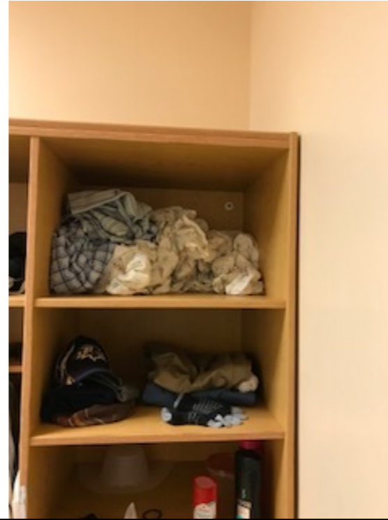
E4- 248 (Sprinkler) - Risk H
